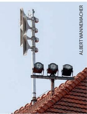
Die Sirene am Dach der Volksschule wurde gegen eine elektronische Sirene ausgetauscht, die auch im Fall eines Stromausfalls autark einsatzfähig ist
