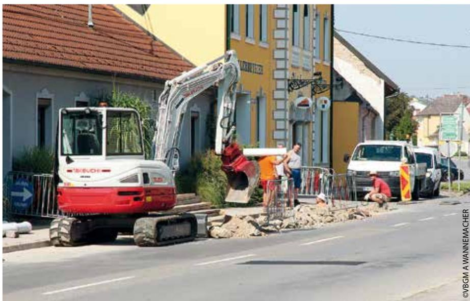
Die leider in Bockfließ immer wieder auftretenden Setzungen von Fahrbahnteilen, hervorgerufen durch einen unbekanntem Erdstall (unterirdisches Gangsystem), verursachen in der Folge Schäden an Wasserleitung und Kanal.
